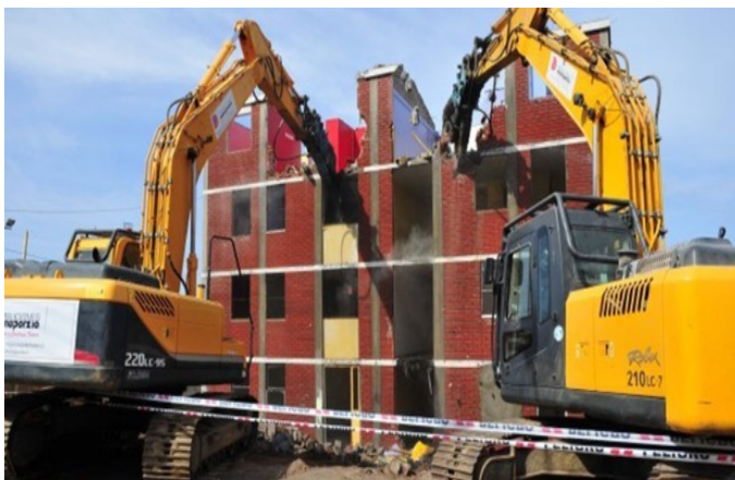
Figura 3. Demolición Edificio Las Dunas
