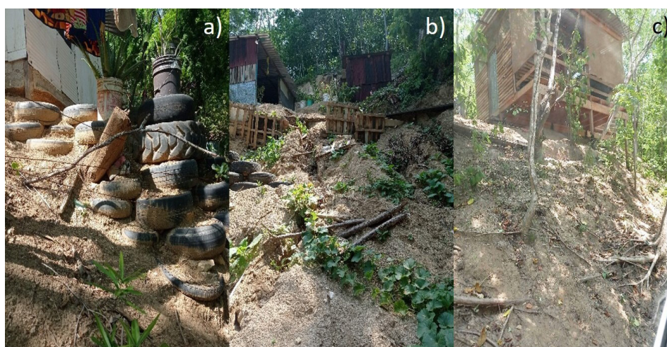
Figura 4. Medidas de contención ante la pérdida de suelo y la formación de procesos gravitacionales
