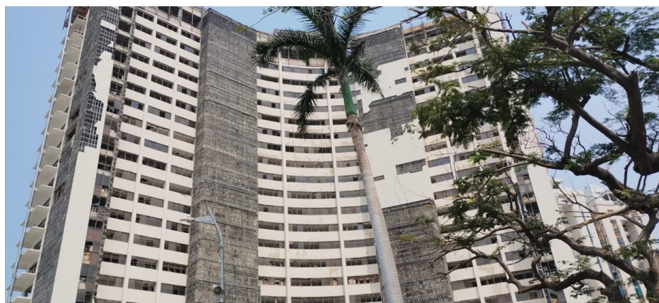
Figura 3. Hotel ubicado en playa Icacos de Acapulco, después del Huracán Otis Fuente: INEGI, 2022.
